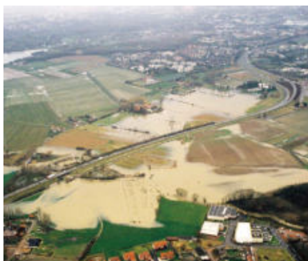
Inondations à Hem, crue de la Marque en janvier 2003 © DIREN
