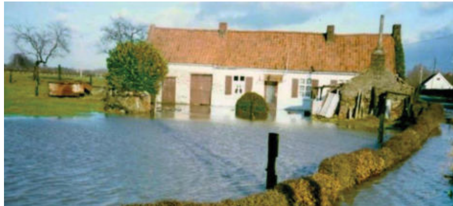
Crue de la Scarpe aval, inondation à Lecelles © Sage Scarpe aval, 19 Juin 2015
