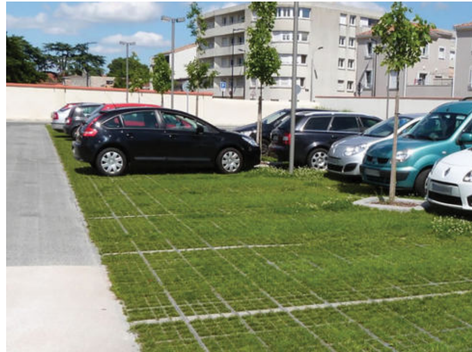
Parking végétalisé ©O2D ENVIRONNEMENT
