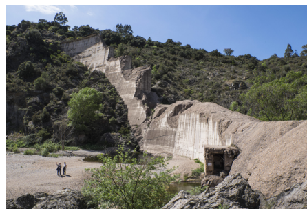
Les restes du barrage de Malpasset dont la rupture, intervenue le 02 décembre 1959, a causé la mort de 423 personnes. Crédit:MAXPPP
