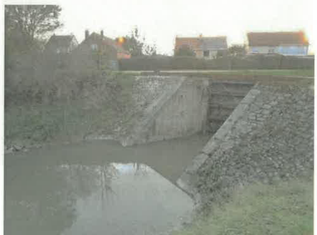
Vue générale depuis le watergang du Schelfvliet vers l'écluse du Schelfvliet
