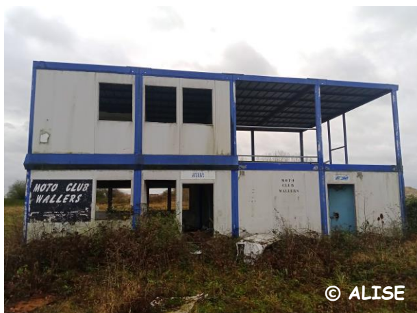
Photo 28 : Ancien bâtiment d'accueil de motocross
