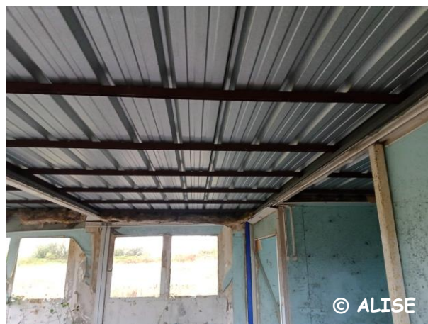
Photo 29 : Toiture en tôle de l'ancien bâtiment d'accueil de motocross
