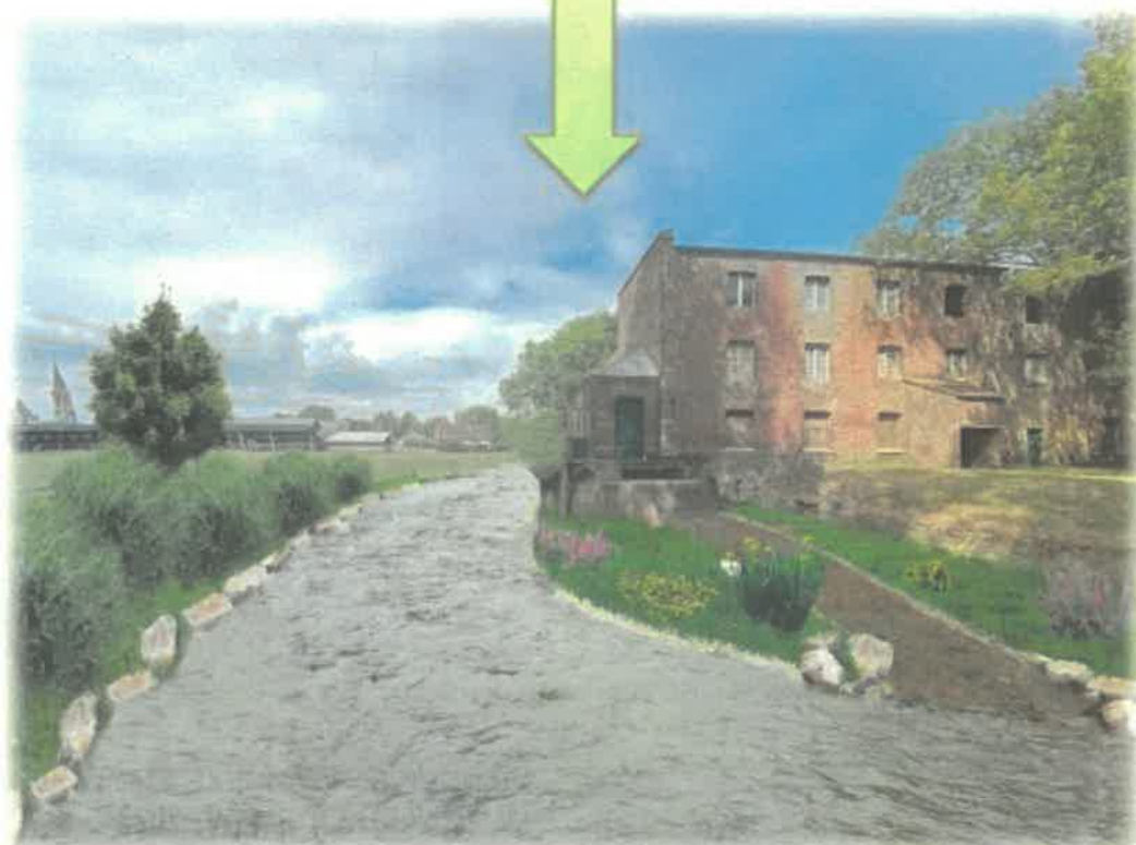
Photomontage vue amont. La passerelle et les deux vannes en entrée de l'ancien canal d'amenée n'y sont pas représentés.
