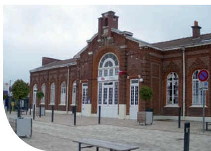
Gare multimodale à Bergues
