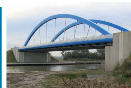
Brouckerque, relèvement du pont de Copenaxfort
