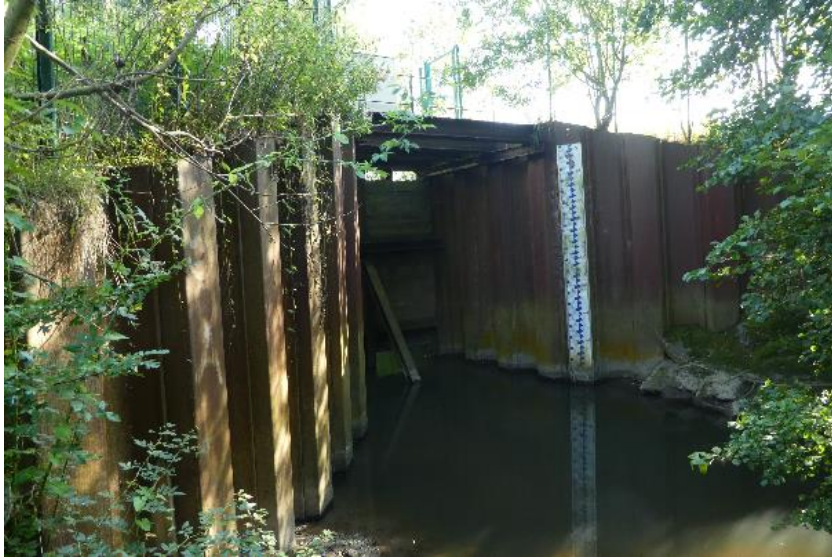
Ouvrage hydraulique sur la Rhonelle, à côté de la ZEC
