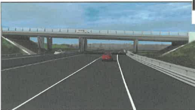
Photomontage d'un passage supérieur à 4 travées (PS075 vu depuis la nouvelle RN2) (Source : Caractéristiques principales des variantes-PRA. Setec, juillet 2019)
