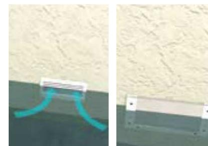
La pose de atardeaux s'accompagne nécessairement de **l'occultation des voies pénétrantes les plus proches du sol**, tels que les ventilations basses. *A contrario* des atardeaux, ici, les dispositifs entravent complètement le passage de l'eau en occultant totalement les entrées d'air. Ces dispositifs sont placés sur les entrées situées sous le niveau du atardeau
