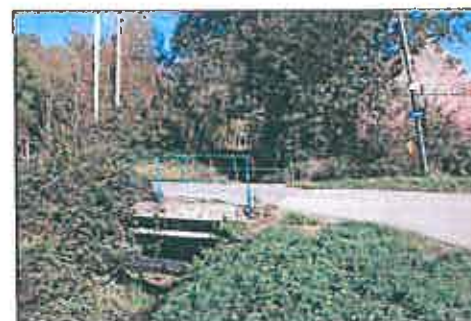
Décérioration du tunage bois sous la passerelle à l'intersection de la voie communale Papote Straete et rue du Pain Sec
