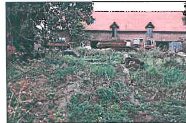
Tout venant déposé le long du cours d'eau – Pneus et autres dans le lit du cours d'eau. Prévoir éventuellement sensibilisation du riverain lors du retrait des déchets
