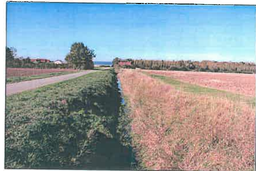
Effondrement de la berge le long de la route, coup de bélier de la canalisation d'eau potable
