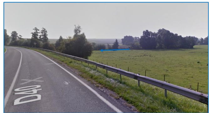
Le remblai de la route départementale D40 à Thiant avec au fond le cours de l'Ecaillon
