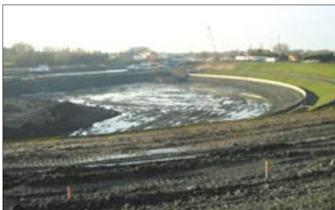
Travaux relatifs au bassin de virement de Dourges
