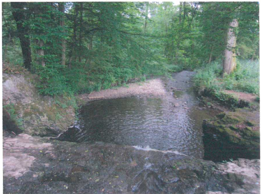
Anor - Barrage de la Galoperie - Vue aval de la chute
