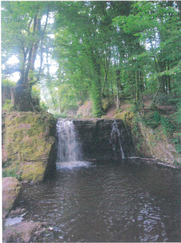
Anor - Barrage de la Galoperie - Vue amont de la chute
