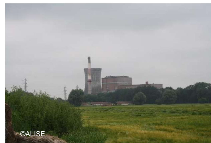
Photo 27 : Ancienne centrale thermique d'Hornaing
