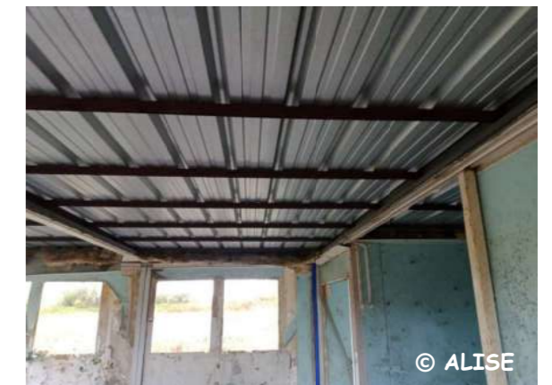
Photo 29 : Toiture en tôle de l'ancien bâtiment d'accueil de motocross
