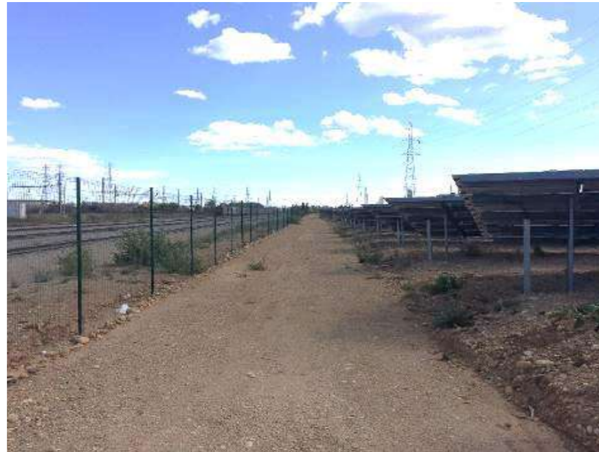
Figure 25 : Exemple de piste périphérique (Source : EDF Renouvelables)
