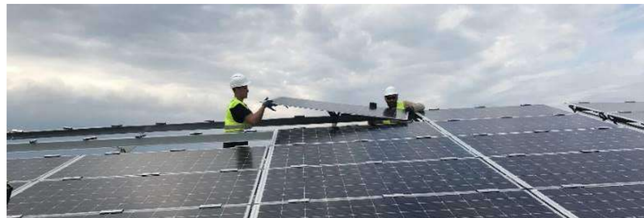
Figure 36 : Pose des modules (Source : EDF Renouvelables)
