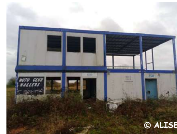
Photo 28 : Ancien bâtiment d'accueil de motocross
