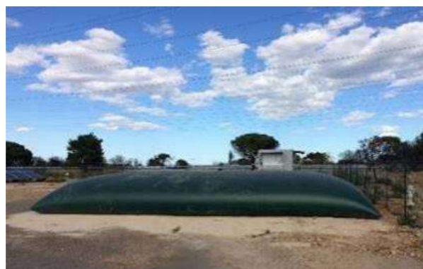
Figure 28 : Exemple d'une citerne souple (Source : EDF Renouvelables)
