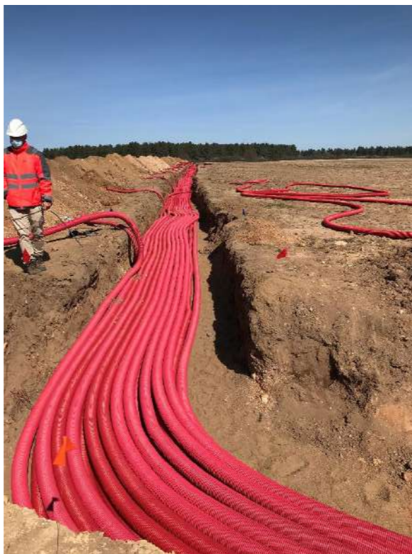
Figure 37 : Exemple de réalisation de tranchées du raccordement interne (Source : EDF Renouvelables)
