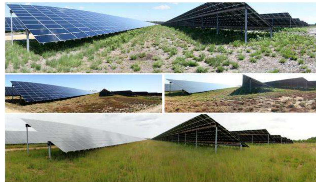
Figure 10 : Illustration du développement de la végétation sur un parc photovoltaïque d'EDF Renouvelables en 5 années Source : EDF Renouvelables
