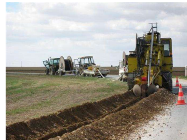
Figure 39 : Réalisation de tranchées du raccordement externe dans l'emprise des voies existantes (Source : EDF Renouvelables)
