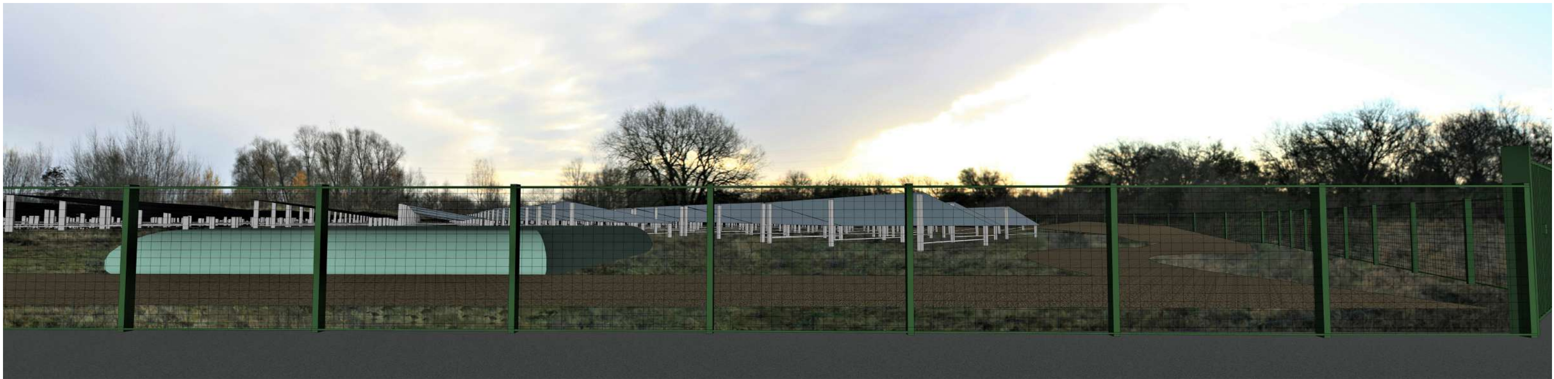
Point de vue n°6 - Vue depuis le portail d'accès au projet
