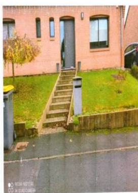
Photo 2 : niveau de la rue habitation environ 1,80m/seuil brut
