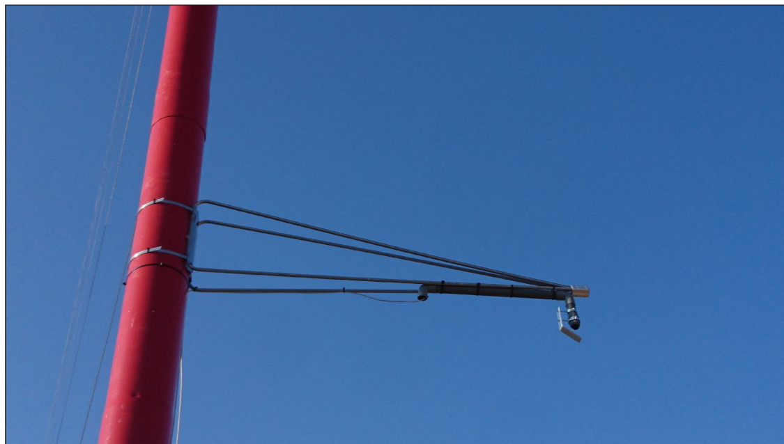
Photo 1 : Exemple de micro posé sur un mât de mesures
