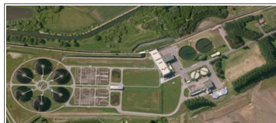
Station d'épuration de Roubaix-Wattrelos
