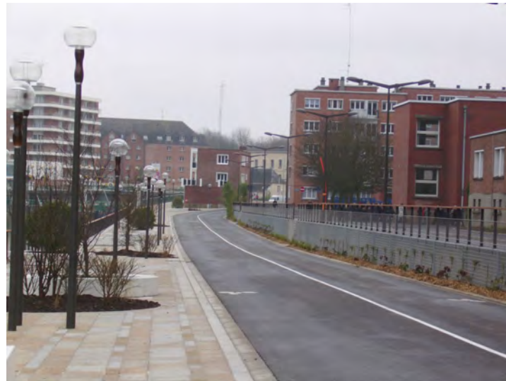
Illustration 118: site propre TCSP et requalification des berges de la Sambre - source : CETE Nord-Picardie
