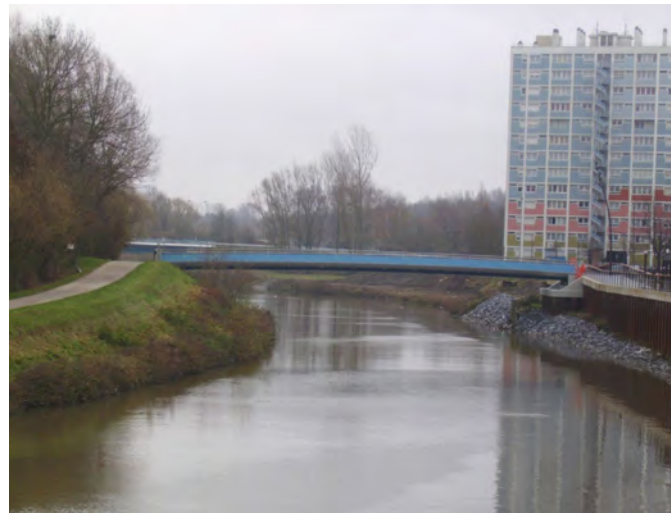
Illustration 125: aménagement d'une liaison piétonne entre le quartier Provinces Françaises et l'Arsenal - source : CETE Nord-Picardie
