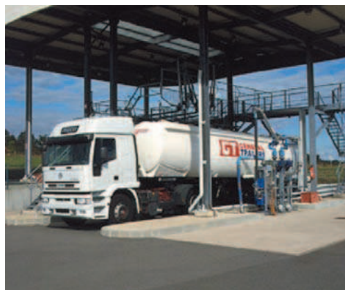
L'aire de déchargement et chargement d'un camion citerne doit être capable de recueillir les égouttures, voire les éventuelles fuites.
