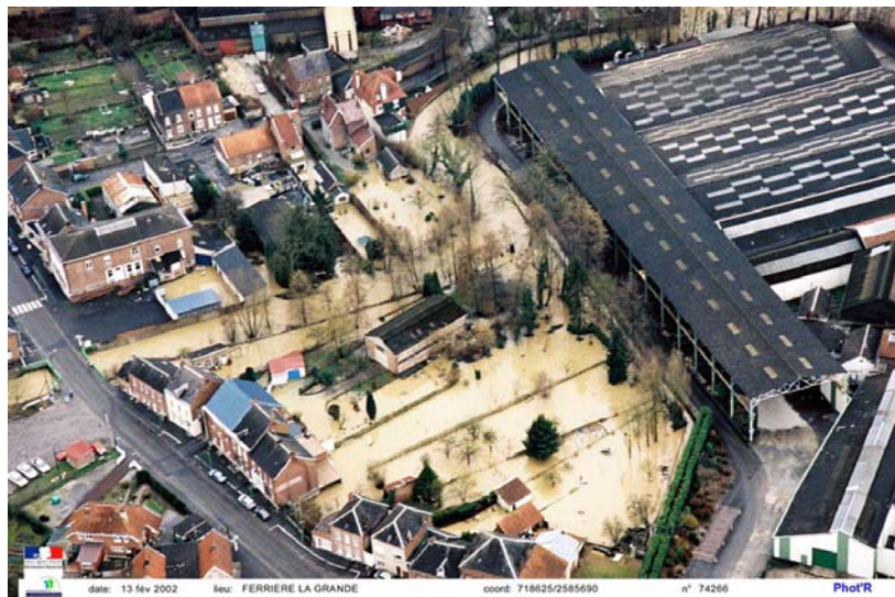
crue de la Solre à Ferrière-la-Grande le 13 février 2002
