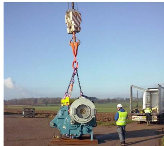
Photographie 4 : Changement d'un multiplicateur sur le parc éolien d'Hermin (Pas-de-Calais).
