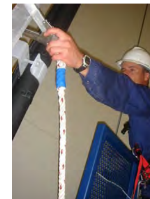
Fixer le mousqueton de la longe de maintien autour des montants de l'échelle.
