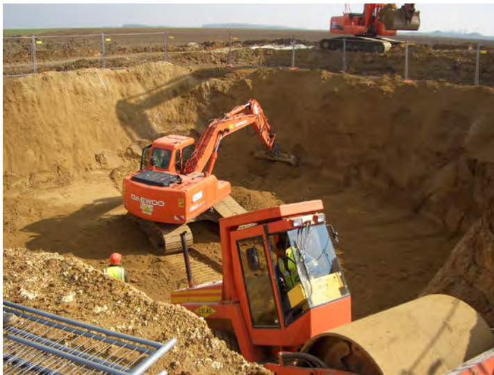
Photographie 16 : Excavation et terrassement pour l'installation des fondations
