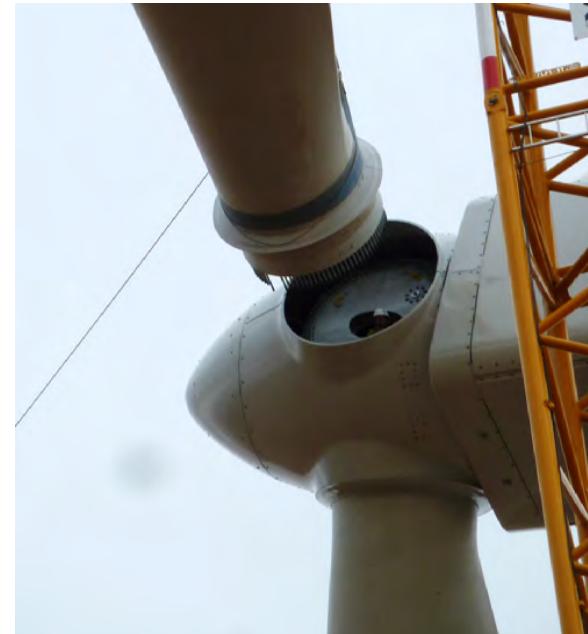
Photographie 27 : Fixation de la pale au moyeu
