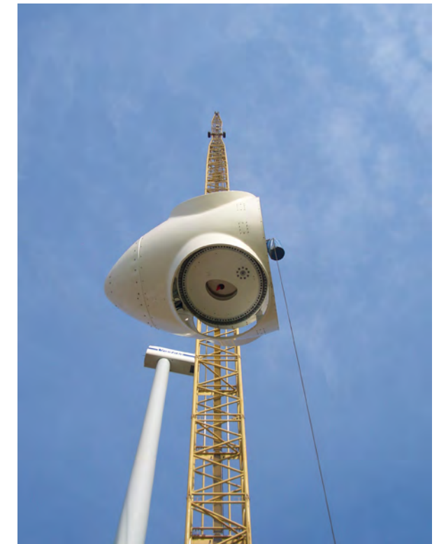
Photographie 23 : Levage du moyeu en fonte
