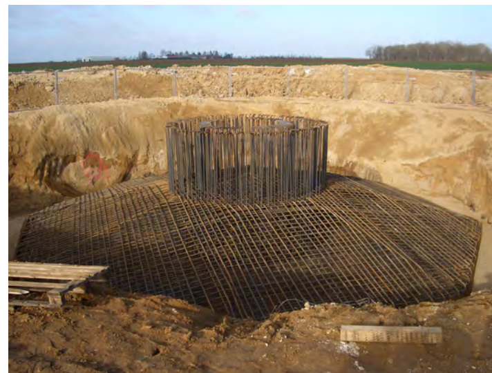
Photographie 10 : Armature d'acier de la fondation
