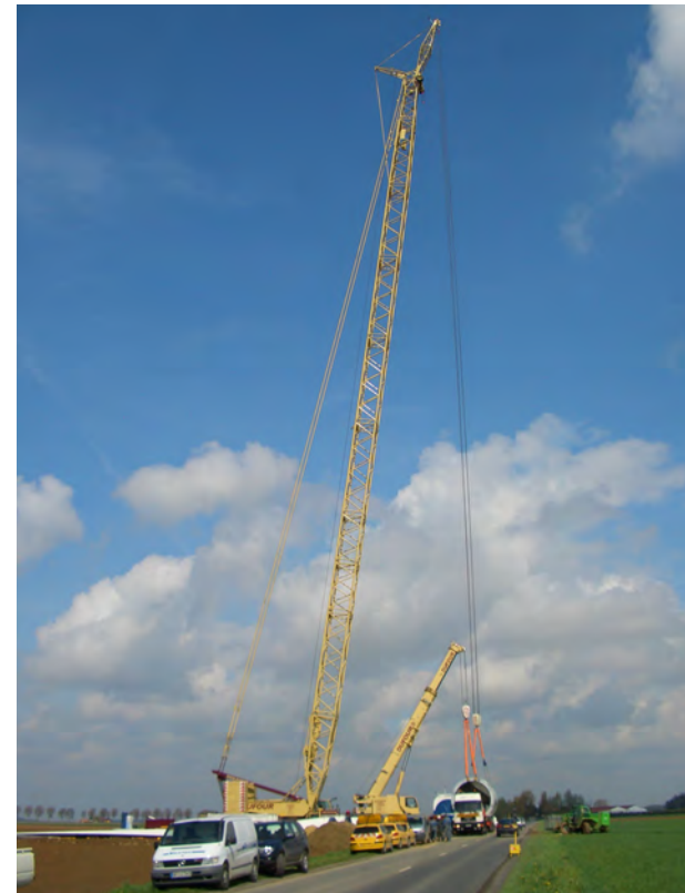
Photographie 19 : Levage d'une section de mât par la grue principale assistée de la grue auxiliaire
