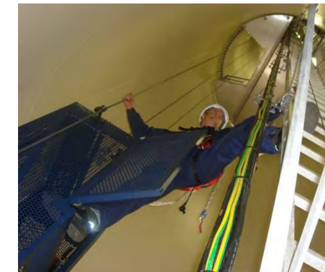
Attraper l'échelle d'une main et placer l'autre pied sur l'échelle.
