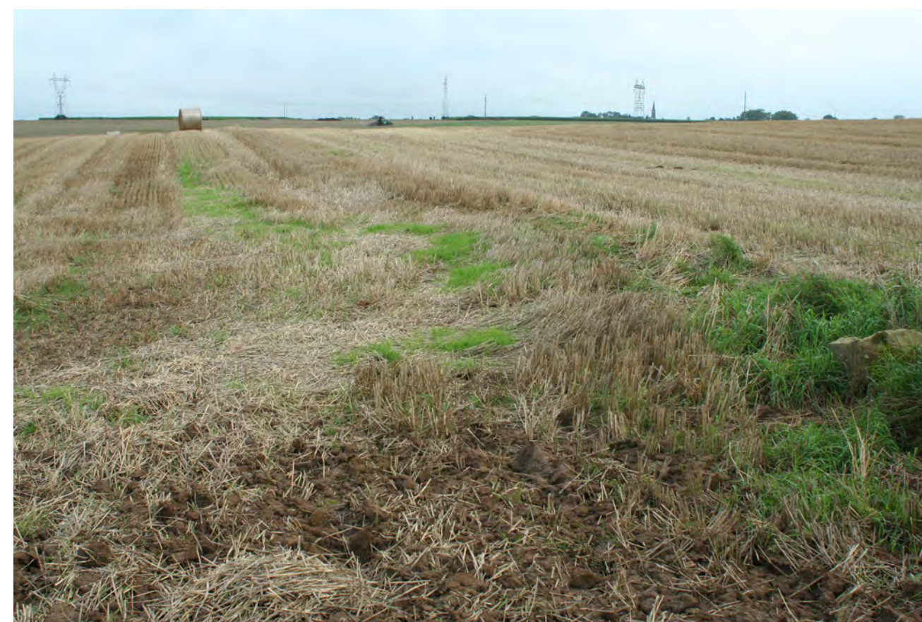
Photographie 31 : Point de vue n°4 : intersection du câblage avec le gazoduc, vue vers l'éolienne E6
