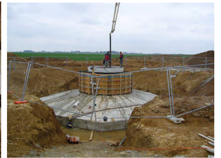
Photographie 12 : Béton solidarissant la caisse d'ancrage au massif
