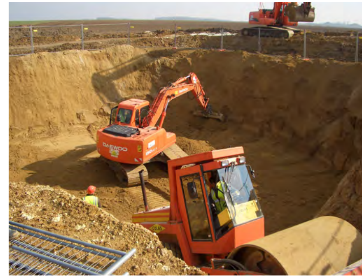
Photographie 8 : Excavation et terrassement pour l'installation des fondations
