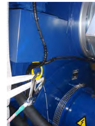
S'attacher en revêtant l'équipement antichute et en le fixant à un point d'ancrage prévu à cet effet à proximité de la sortie de secours.
