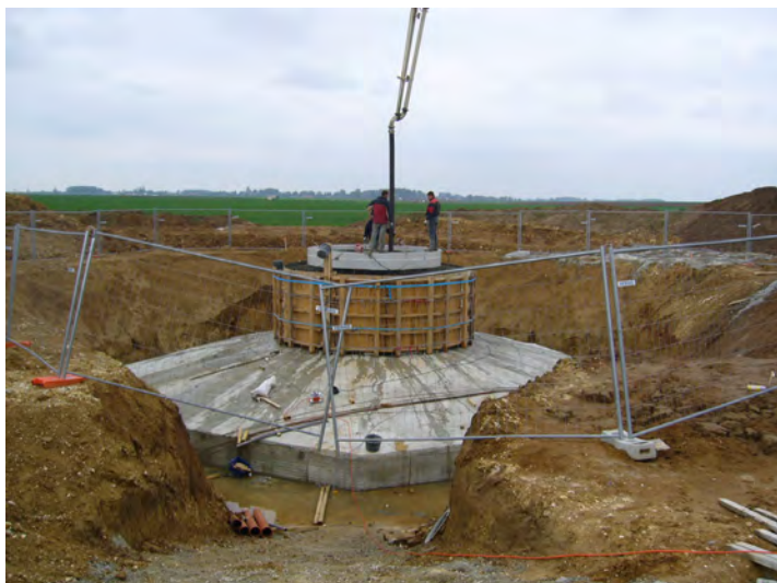
Photographie 17 : Coulage du béton solidarissant la virole au massif
