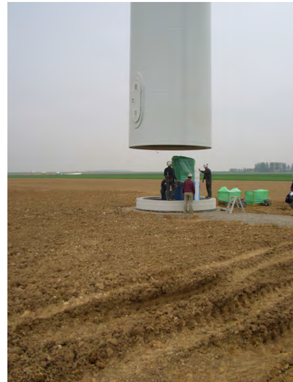
Photographie 20 : Ajustement de la première section de mât sur l'embase
