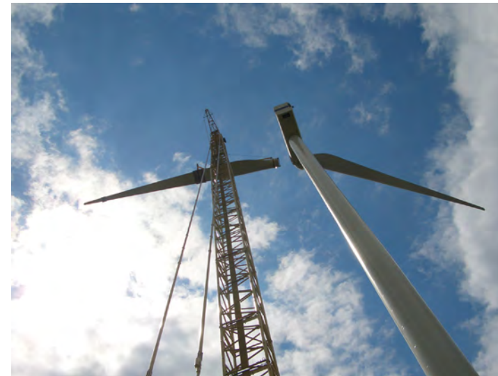
Photographie 21 : Assemblage d'une pale
