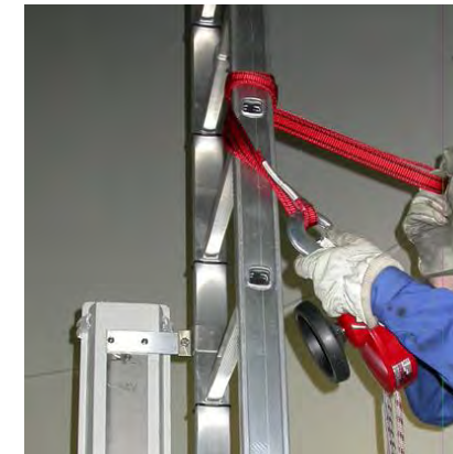
Accrocher le dispositif de descente aux barreaux de l'échelle.
