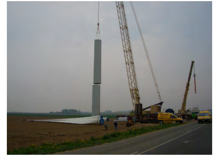
Photographie 22 : Assemblage des deux premières sections du mât
