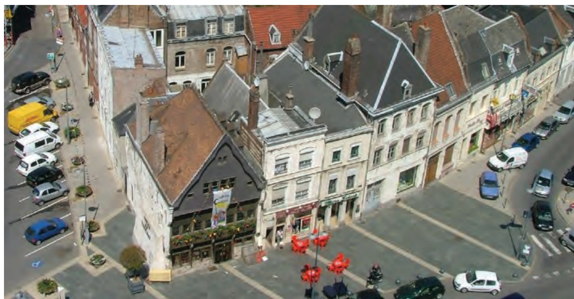
Vue d'oiseau de la Maison Espagnole. Source : www.aspecambrai.org
