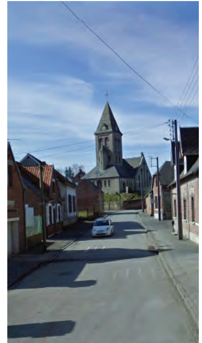
Vue de l'édifice depuis la rue de l'église. Source : Google Street View
