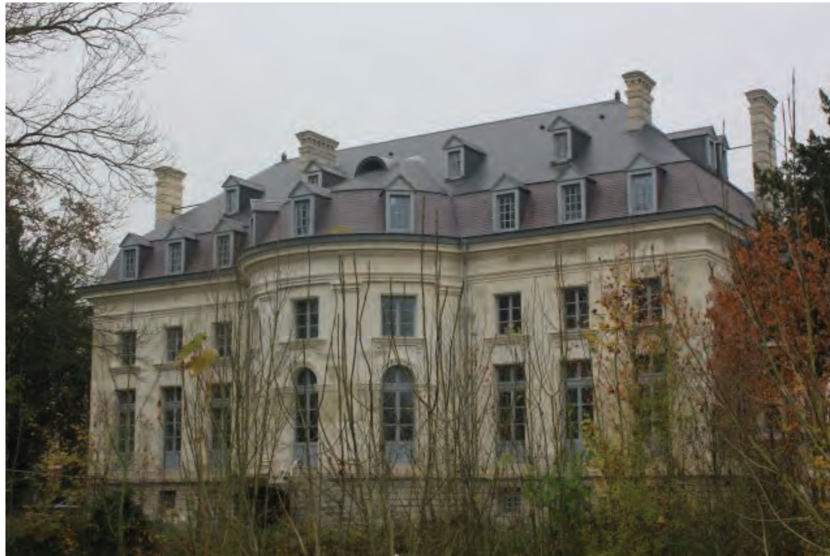
Photographie du Château d'Avesnes © BATAIS Couverture
