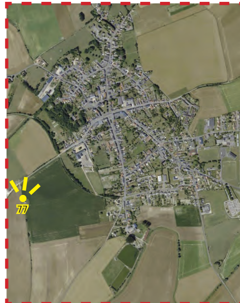
Vue aérienne. Source : Géoportail
