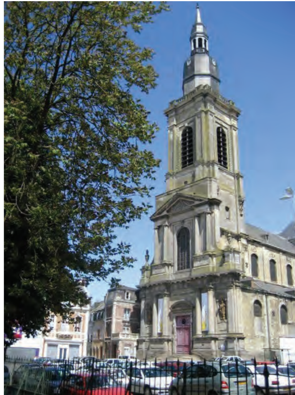
Église Saint-Géry. Source : www.aspecambrai.org
