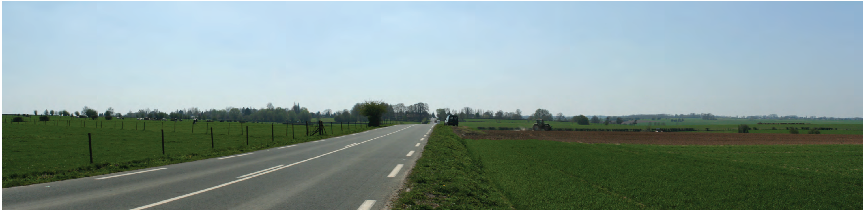
VUE DE L'EXISTANT:
