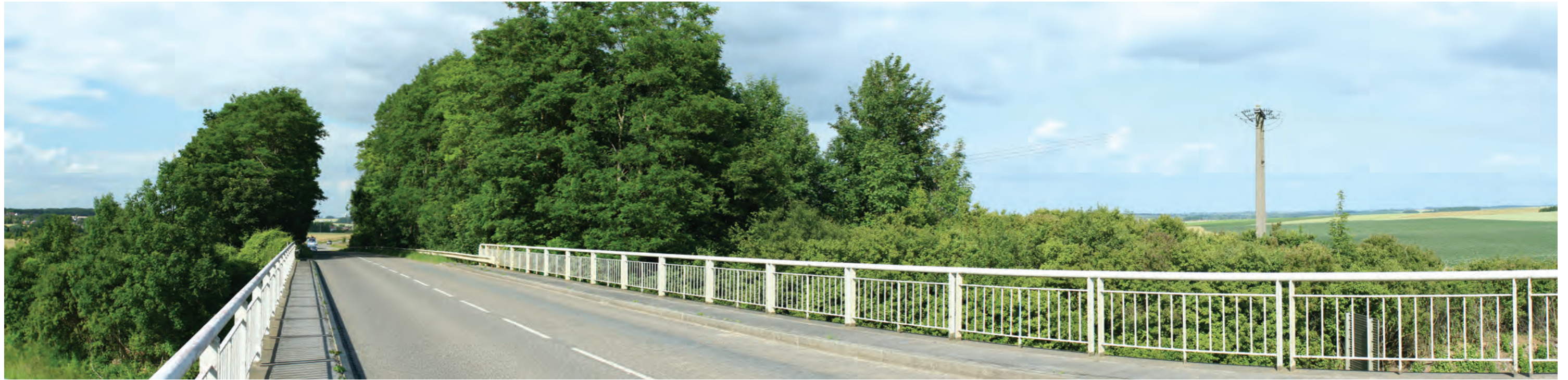
VUE DE L'EXISTANT:
