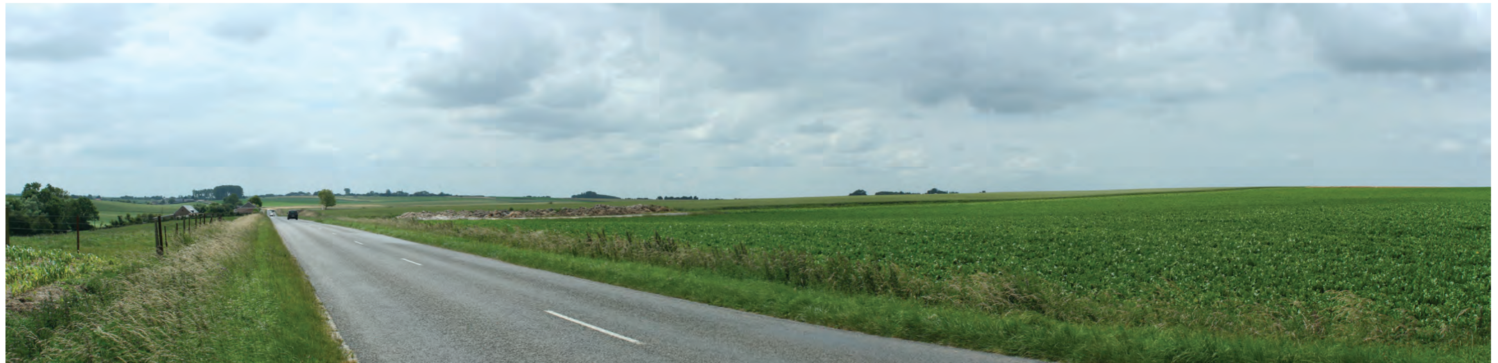
VUE DE L'EXISTANT:
