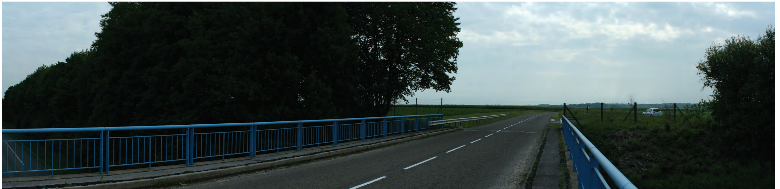
VUE DE L'EXISTANT:
