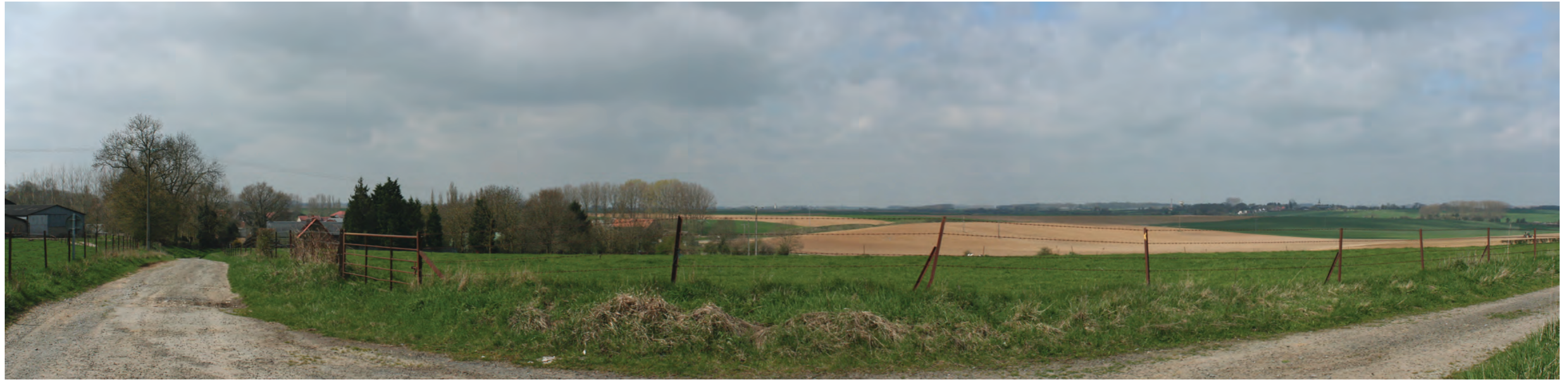
VUE DE L'EXISTANT:
