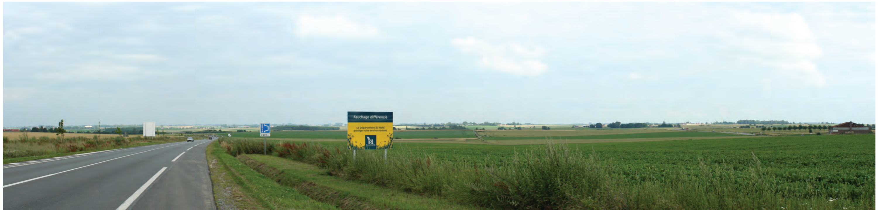
VUE DE L'EXISTANT:
