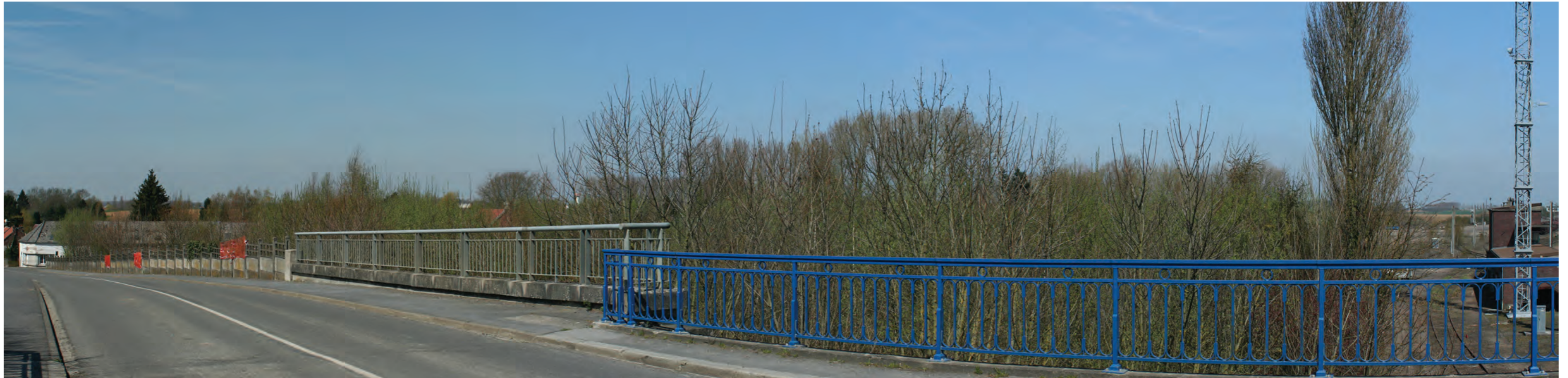
VUE DE L'EXISTANT:
