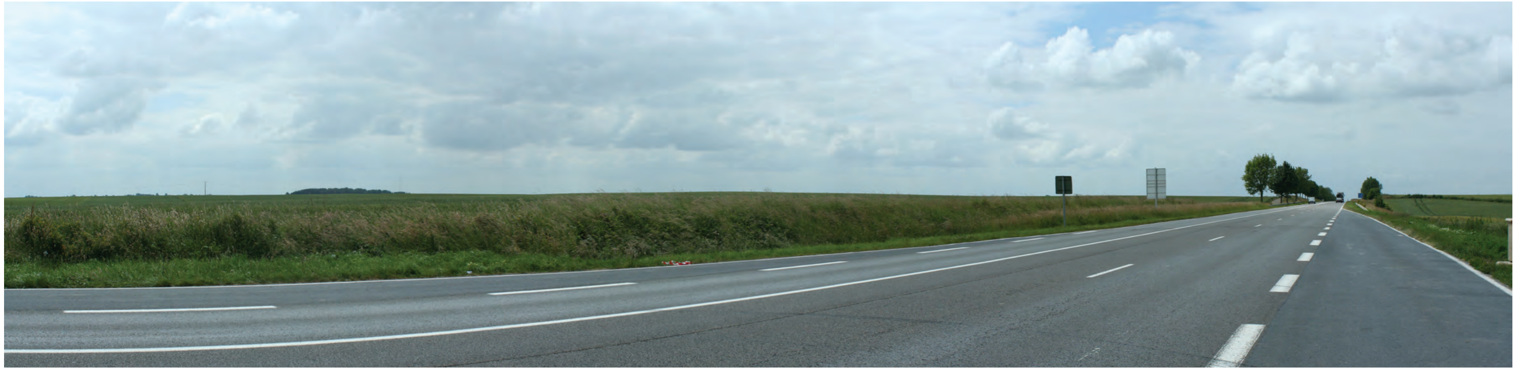
VUE DE L'EXISTANT:
