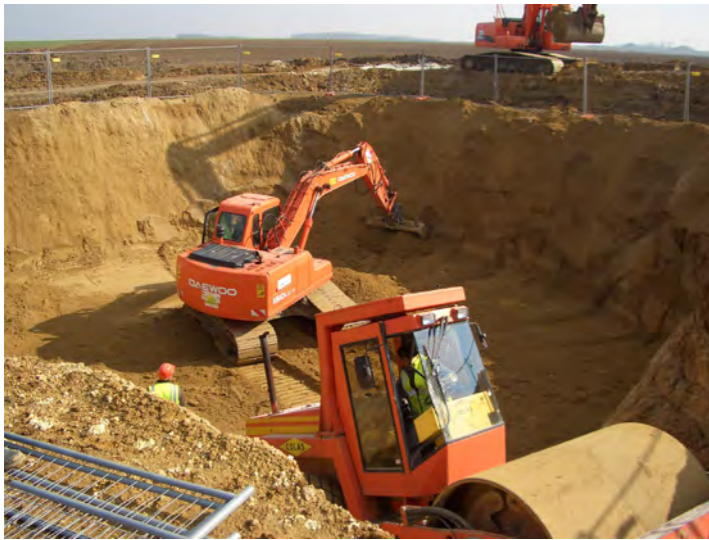
Photographie 7 : Excavation et terrassement pour l'installation des fondations
