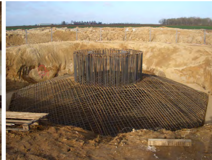
Photographie 13 : Armature d'acier de la fondation
