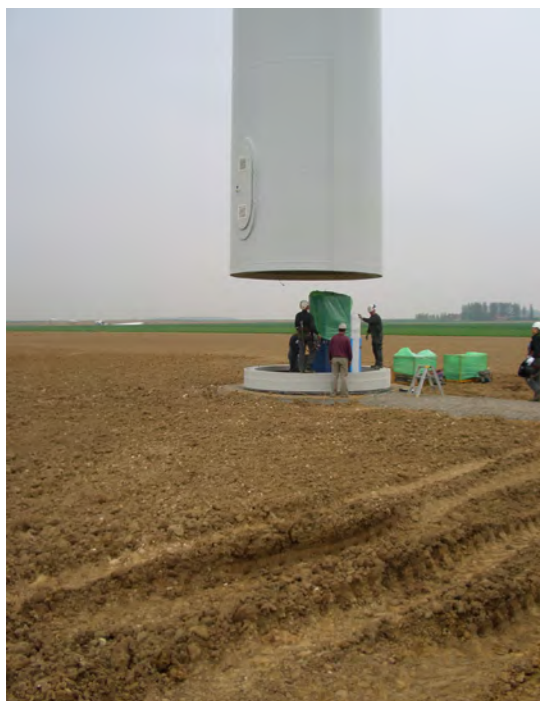
Photographie 18 : Ajustement de la première section de mât sur l'embase
