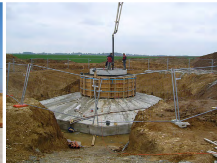
Photographie 14 : Coulage du béton solidarissant la virole au massif
