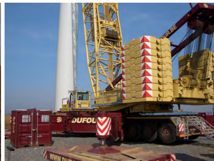
Photographie 12 : Grue principale sur l'aire de grutage, 180 t de contrepoids assure sa stabilité
