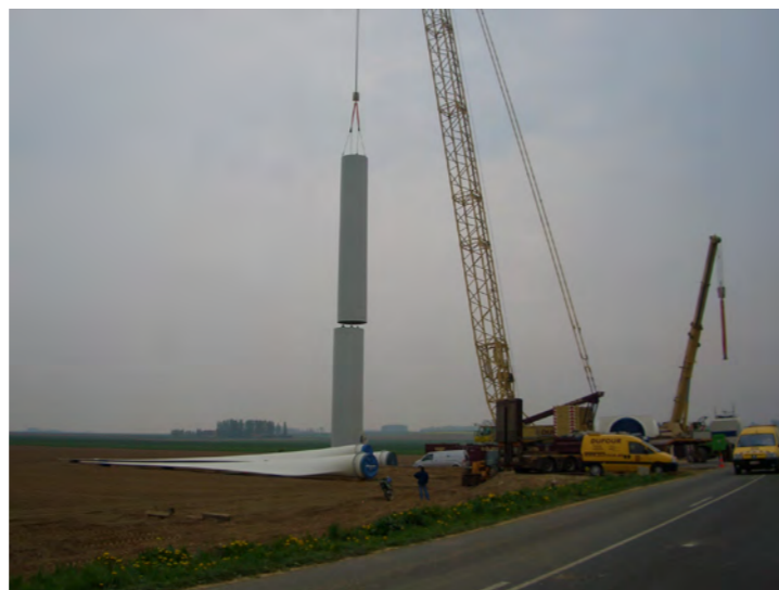
Photographie 20 : Assemblage des deux premières sections du mât
