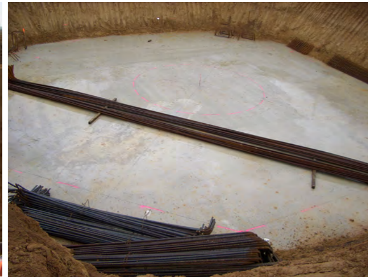
Photographie 10 : Béton de propreté avant le montage de l'armature de ferraille
