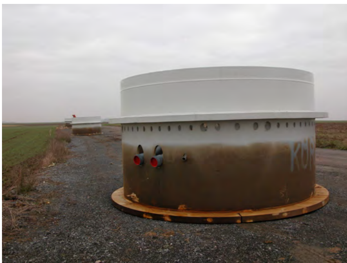
Photographie 8 : Virole (embase) de l'éolienne, stockée sur une aire stabilisée
