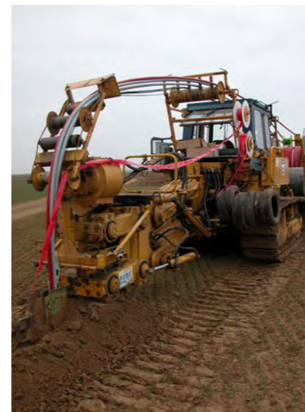
Photographie 2 : Pose des câbles avec un soc vibrant, limitant les dégâts dans les champs
