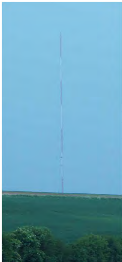
Mâts de mesure en treillis métallique sur projet éolien (Pas-de-Calais).
