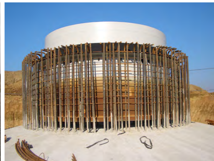
Photographie 11 : Insertion de la virole dans l'armature de la fondation
