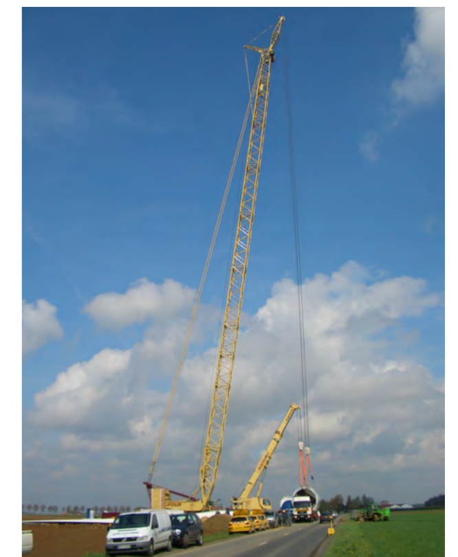
Photographie 17 : Levage d'une section de mât par la grue principale assistée de la grue auxiliaire
