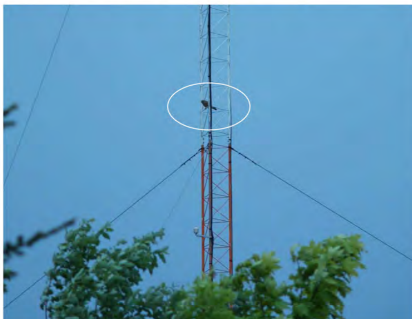
Photographie 72 : Exemples d'un mât de mesure de vent et de ses effets sur l'avifaune
