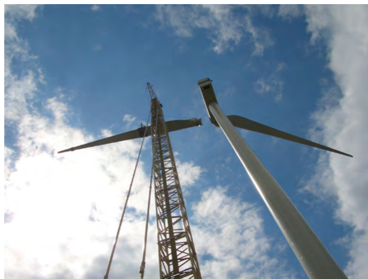
Photographie 21 : Assemblage d'une pale
