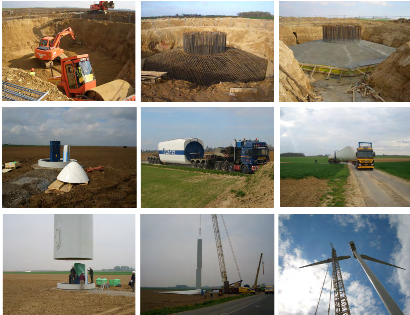
Photographie 2 : Aperçu des différentes phases de travaux
