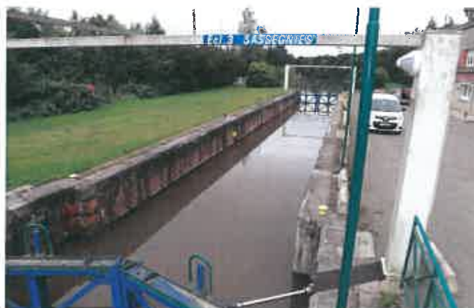
Fig.13 : Ecluse - vue du sas
