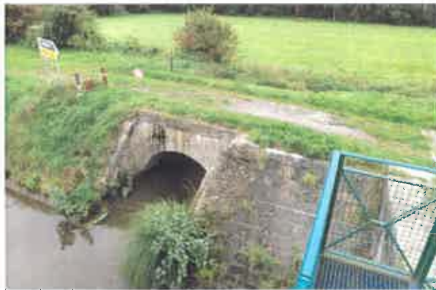
Fig.10 :Rejet du contre-fossé en rive droite dans la Sambre canalisée
