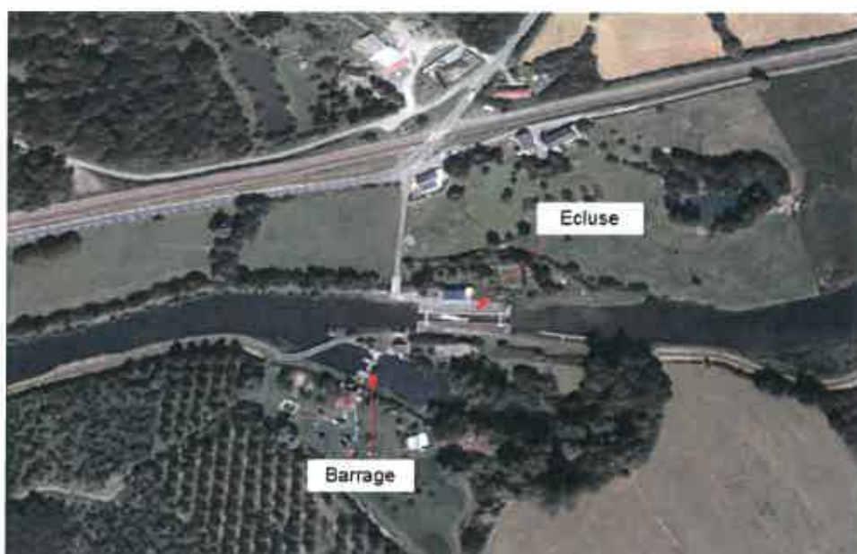
Fig.12 : Localisation des ouvrages (source Google Earth)
