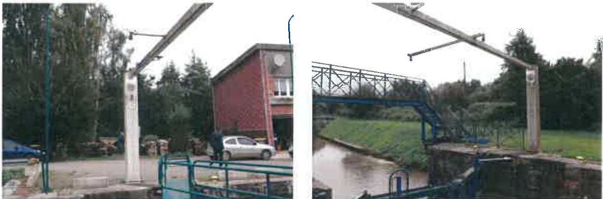
Fig.17 : Sonde amont et sonde aval
