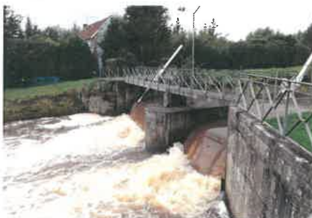
Fig.15 : Barrage vue aval (en rive droite)
