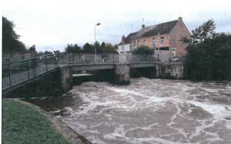
Fig.9 :Barrage de Hachette en rive gauche - vue aval
