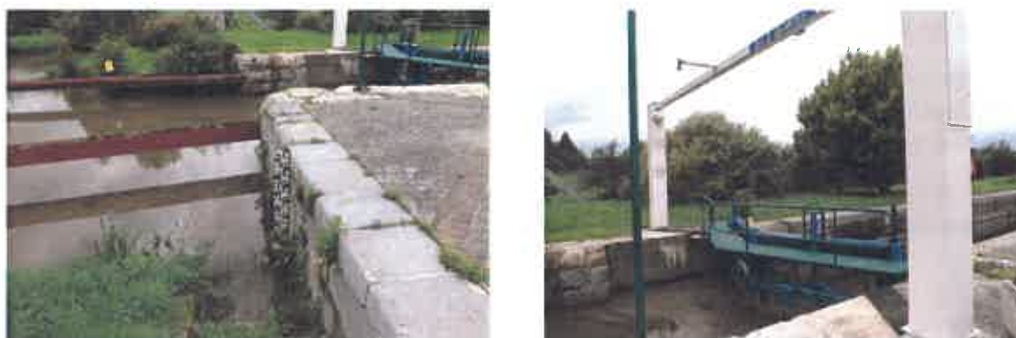
Fig.18 : Echelle et sonde amont
