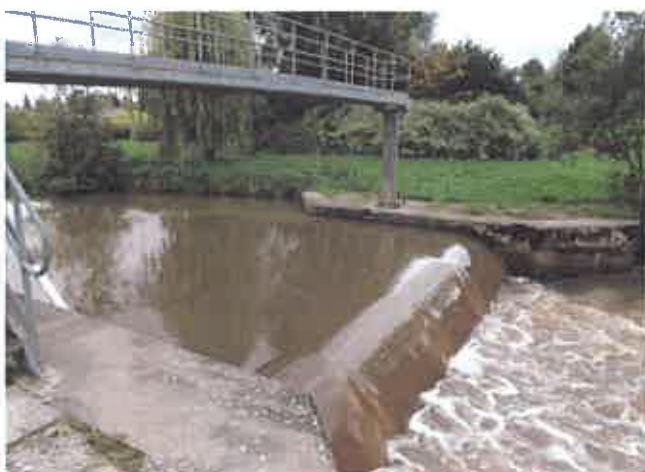
Fig.16 : Barrage vue aval (sur la rive gauche)
