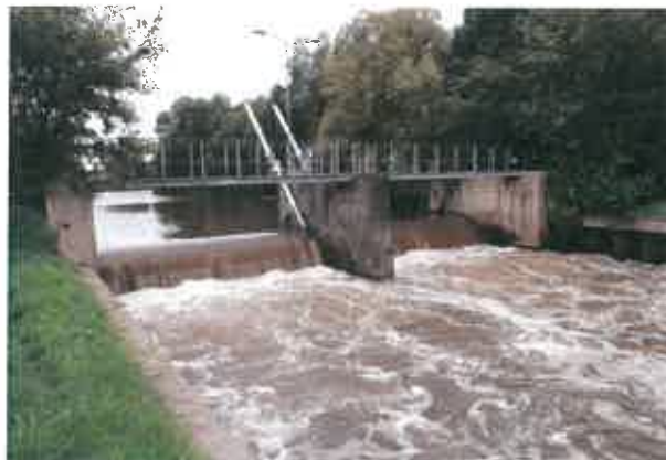
Fig.9 :Barrage de Pont-sur-Sambre en rive gauche - vue aval
