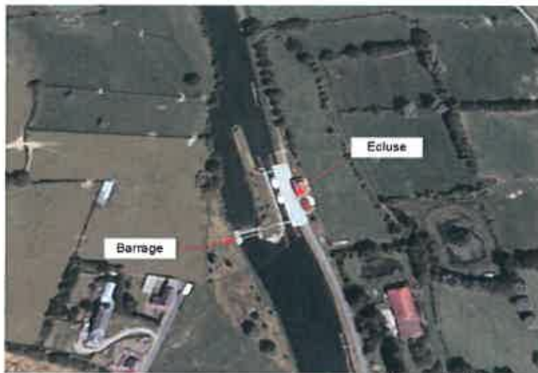
Fig.14 : Localisation des ouvrages (source Google Earth)
