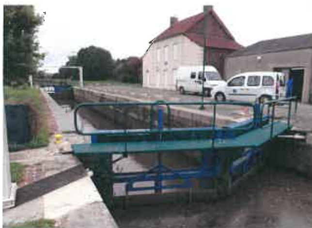
Fig.15 : Ecluse - vue du sas
