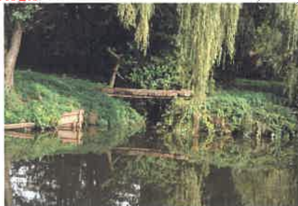
Fig.12 :rejet du ruisseau Bois Georges dans la Sambre canalisée
