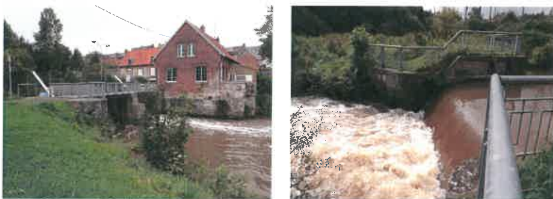
Fig.9 :Barrage de Berlainmont passes en rive gauche et passe dans bras de décharge en rive droite - vue aval
