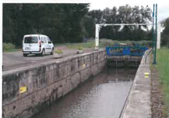
Fig.14 : Ecluse - vue du sas
