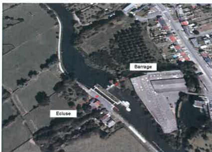
Fig.13 : Localisation des ouvrages (source Google Earth)
