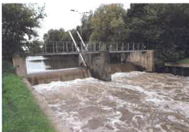
Fig.15 : Barrage vue aval (sur la rive gauche)
