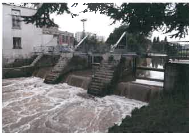
Fig.9 :Barrage de Hautmont en rive droite - vue aval
