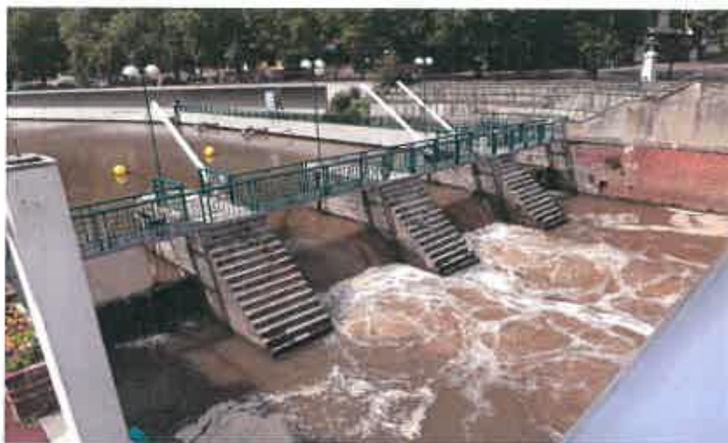
Fig.9 :Barrage de Maubeuge en rive gauche - vue aval
