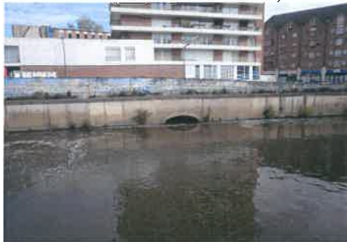
Fig.13 :Rejet du cours d'eau de la Pisselotte dans la Sambre canalisée
