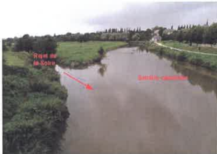
Fig.10 :Rejet de la Solre en rive droite dans la Sambre canalisée sur le bief Marpent/Maubeuge
