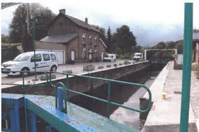
Fig.16 : Ecluse - vue du sas
