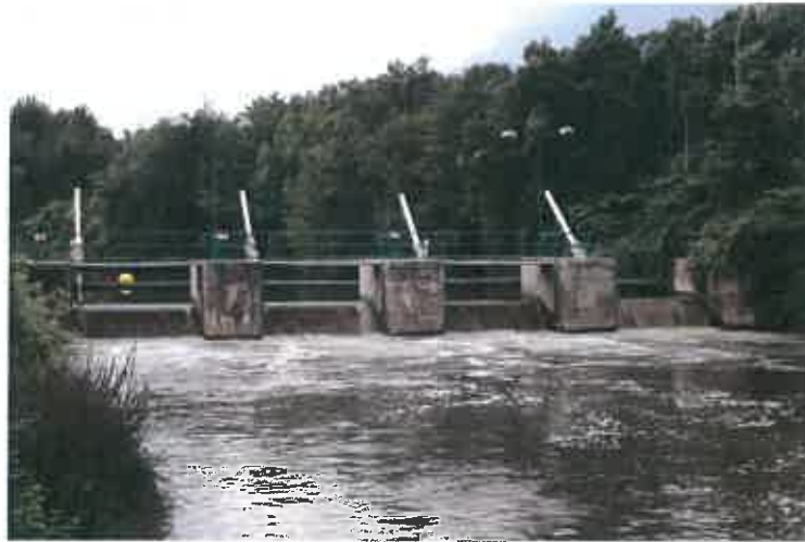
Fig.17 : Barrage vue aval (sur la rive gauche)
