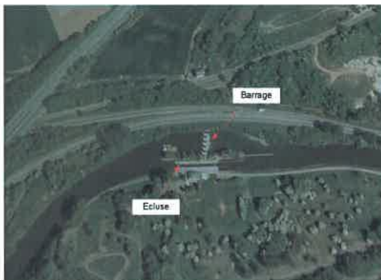
Fig.15 : Localisation des ouvrages (source Google Earth)
