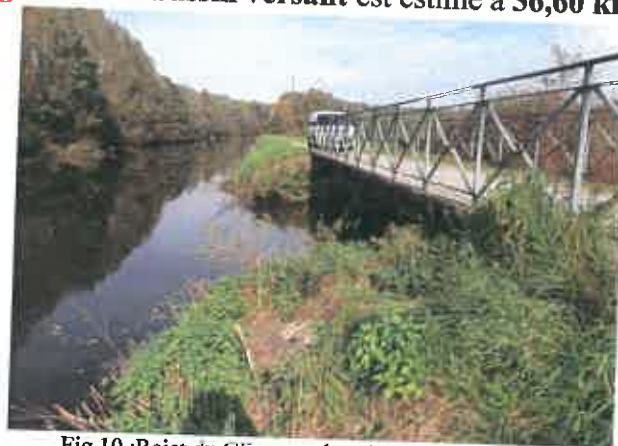
Fig.10 :Rejet du Cligneux dans la Sambre canalisée
