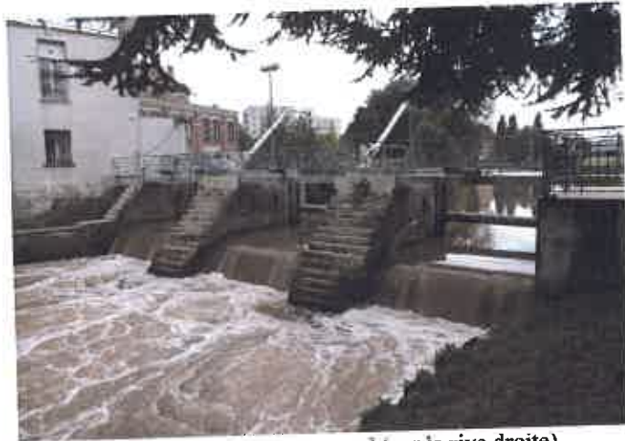
Fig.14 : Barrage vue aval (sur la rive droite)
