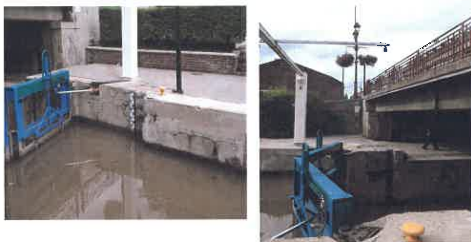
Fig.16 : Echelle et sonde aval
