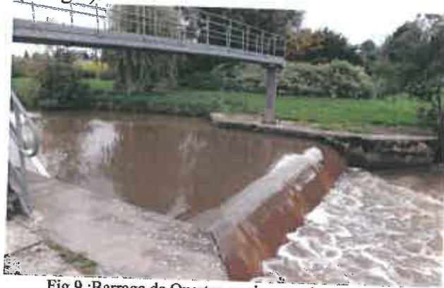
Fig.9 :Barrage de Quartes en rive gauche - vue aval
