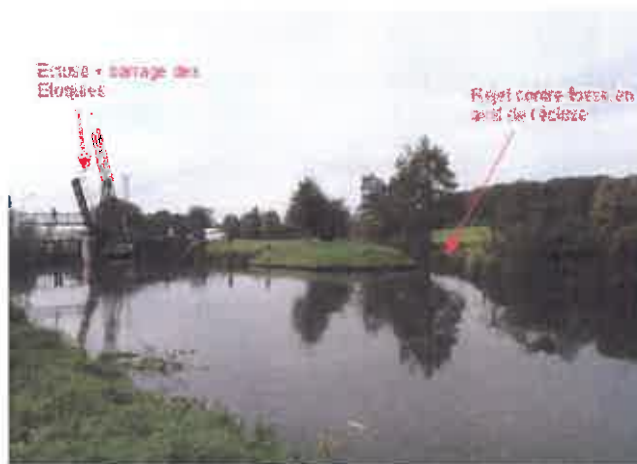
Fig.12 : Rejet du contre-fossé en aval de l'écluse des Etoquies
