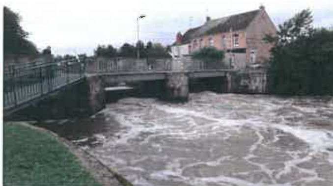
Fig.22 : Barrage vue aval (en rive gauche)
