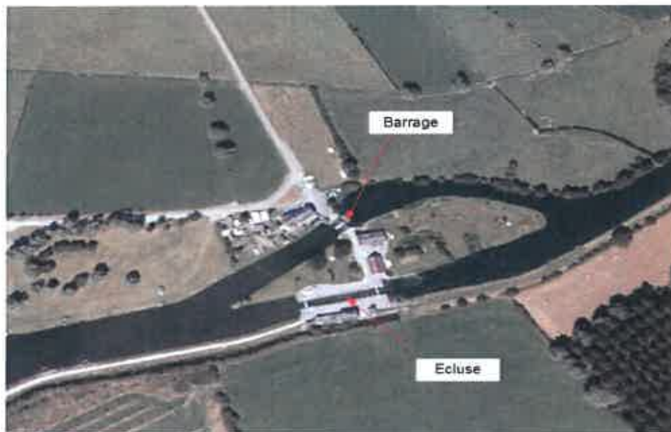
Fig.19 : Localisation des ouvrages (source Google Earth)
