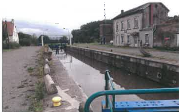
Fig.20 : Ecluse - vue du sas
