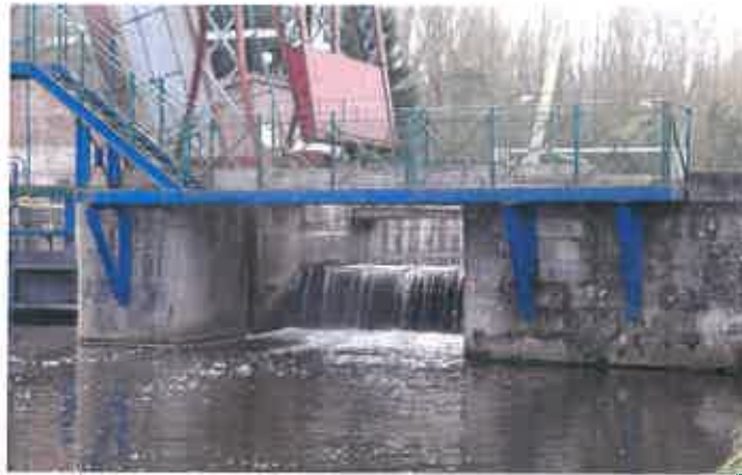
Fig.9 :Barrage des Etoquies en rive gauche - vue aval
