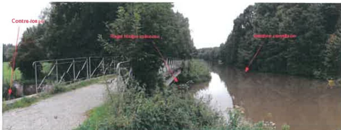
Fig.10 :Rejet de l'Helpe mineure dans la Sambre canalisée
