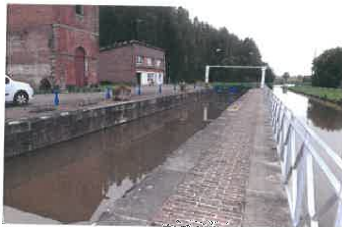
Fig.12 : Ecluse - vue du sas
