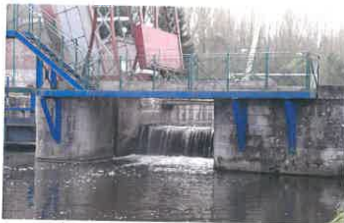
Fig.14 : Barrage vue aval (en rive gauche)
