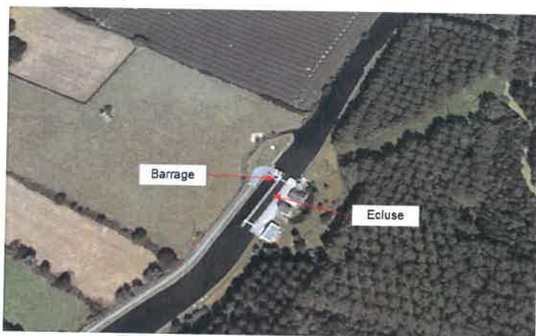
Fig.11 : Localisation des ouvrages (source Google Earth)
