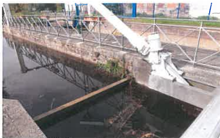
Fig.9 :Barrage de Landrecies - vue aval
