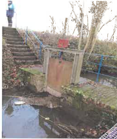
Fig.11 : Prise d'eau de Vinchy -- en travers de la rigole d'alimentation (vue amont)
