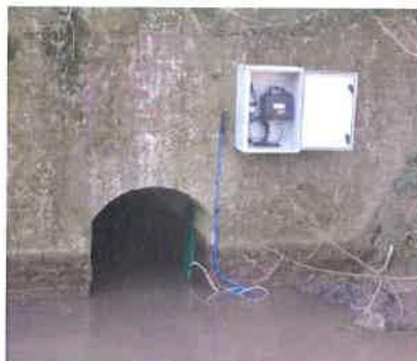
Fig.18 : Station débitmétrique
