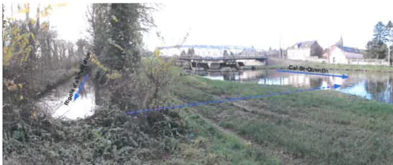
Fig.14 : Rejet de la rigole d'alimentation dans le Canal de Saint-Quentin
