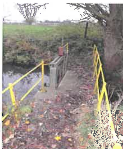
Fig.14 : Prise d'eau de Bantouzelle – en travers de la rigole d'alimentation
