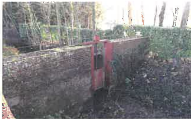
Fig.18: Prise d'eau de Vaucelles – en travers du contre-fossé
