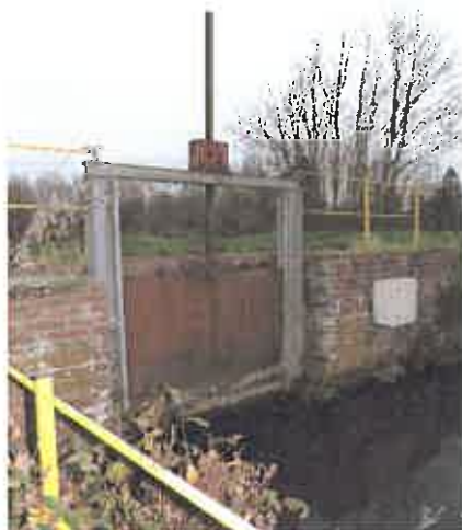
Fig.15: Prise d'eau de Bantouzelle – côté canal
