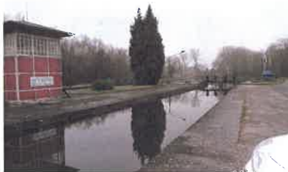
Fig. 5 : Exemple d'écluse sur le Canal de Saint-Quentin : l'écluse de Moulin Lafosse
