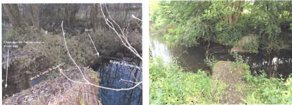
Fig.13 : Seuil en travers la rigole d'alimentation
