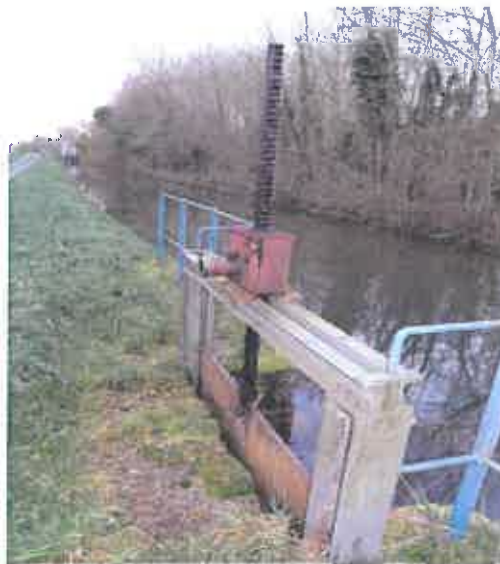
Fig.14 : Vanne de de prise d'eau (avec vue de la rigole d'alimentation en amont)
