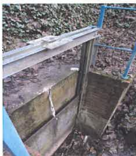
Fig.12: Prise d'eau de Talma – vanne d'alimentation de la rigole
