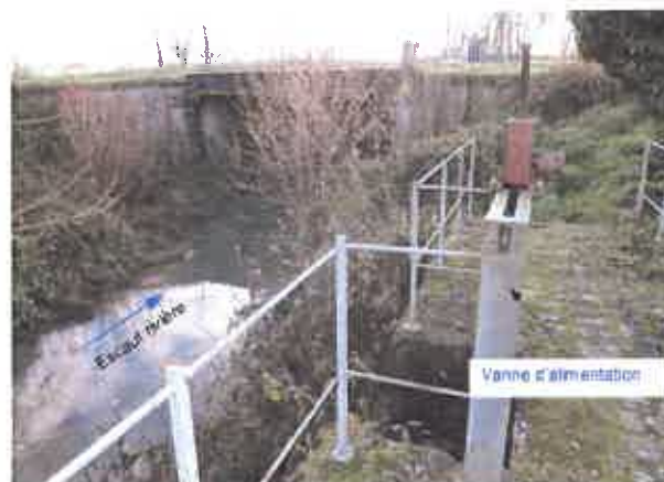
Fig.12 : Vanne 1 – vanne d'alimentation
