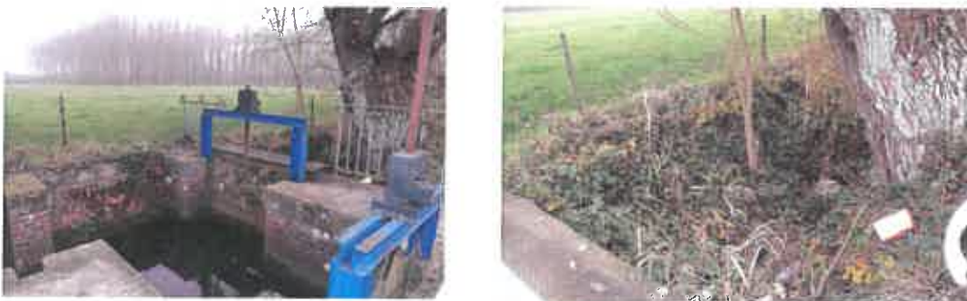
Fig.23 : Prise d'eau de Proville – vanne en travers du contre-fossé (vue amont et aval)
