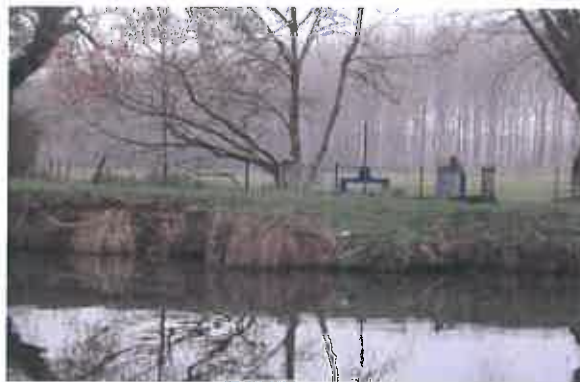
Fig.10 : Prise d'eau de Proville vue du Canal de Saint-Quentin
