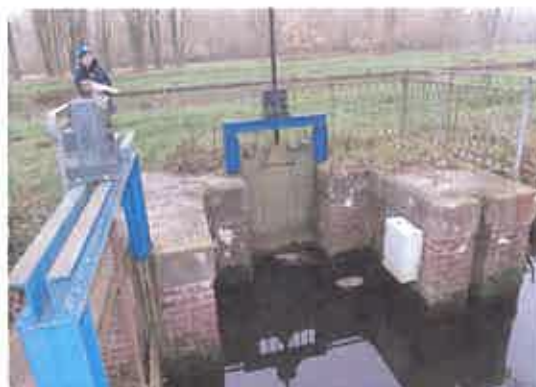
Fig.13 : Prise d'eau de Proville - vanne alimentant le canal (vue amont, vue du contre-fossé)
