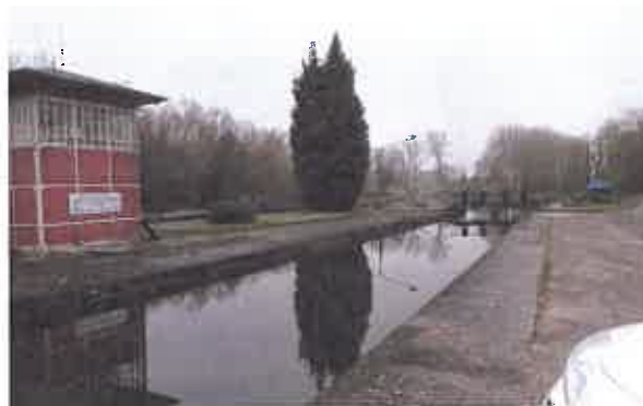
Fig. 5 : Exemple d'écluse sur le Canal de Saint-Quentin : l'écluse de Moulin Lafosse
