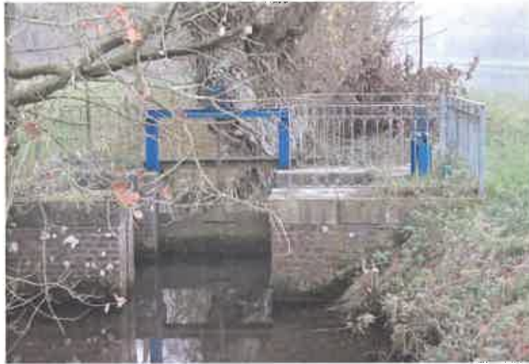
Fig.12 : Prise d'eau de Proville – vanne en travers du contre-fossé (vue amont)
