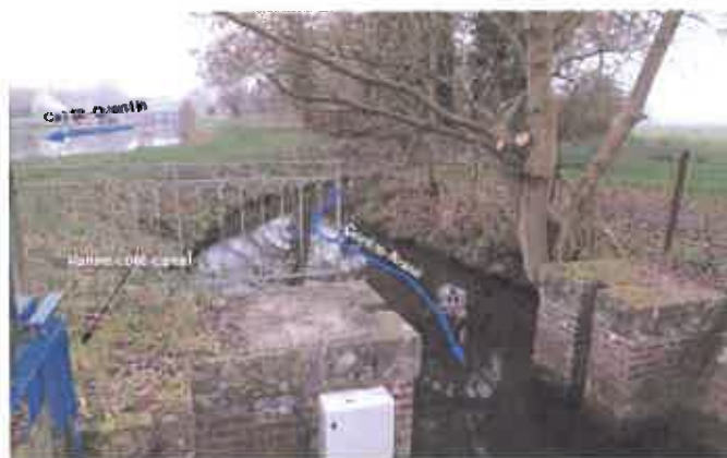
Fig.22 : Vue du contre-fossé en amont de la prise d'eau de Proville
