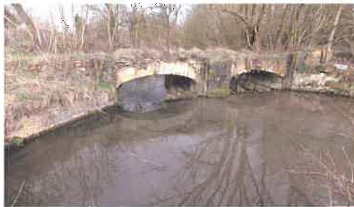
Fig.21 : Vue amont du barrage à poutrelles
