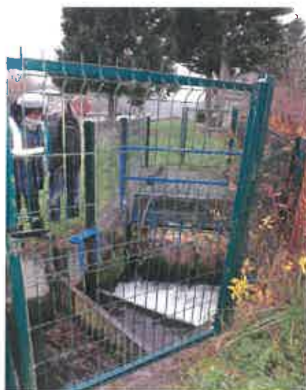
Fig.24 : By-pass au niveau de l'écluse du Bosquet
