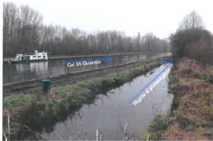
Fig.13 : Exutoire de la prise d'eau dans la Canal de Saint-Quentin
