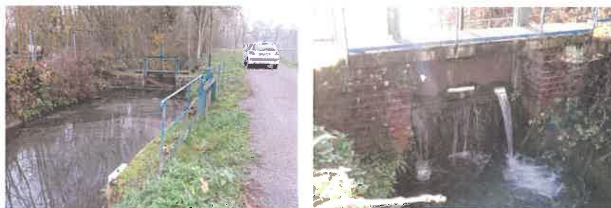
Fig.12 : Prise d'eau de Honnecourt – en travers de la rigole (vue amont et aval)
