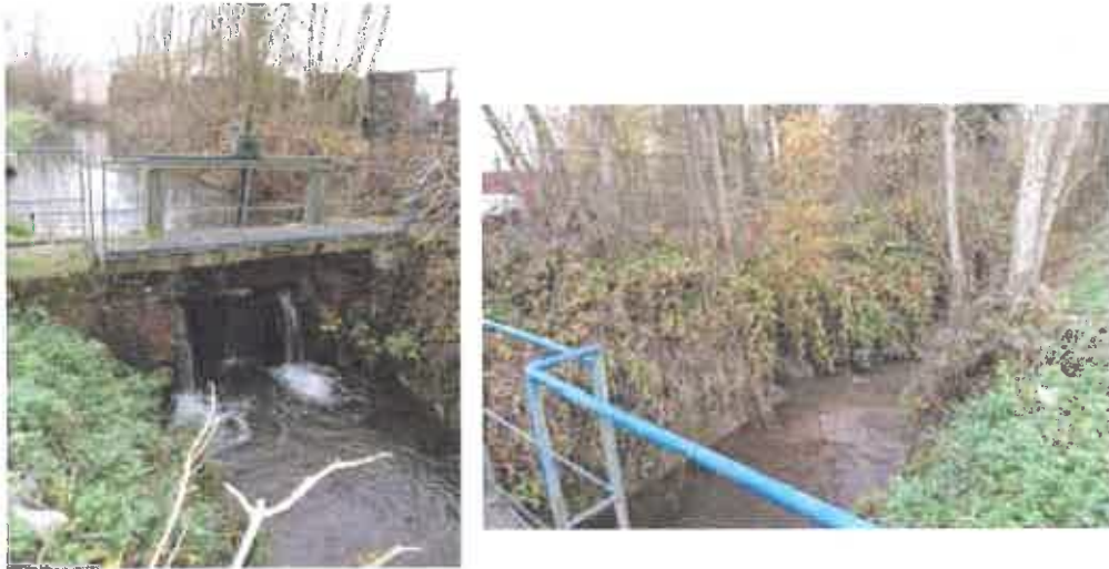
Fig.21 : Vue aval de la vanne et de la rigole
