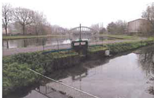
Fig.13 : Prise d'eau de Honnecourt – coté canal
