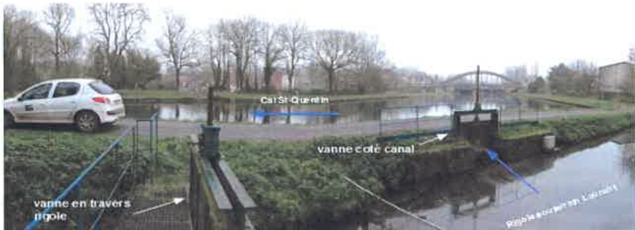
Fig.19 : Alimentation de la prise d'eau par la rigole du souterrain Laurent
