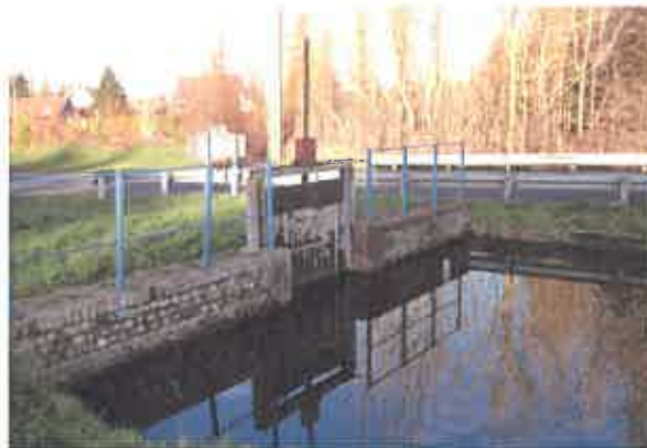
Fig.12: Prise d'eau de Crèvecoeur – vanne d'alimentation du canal St Quentin par la rigole (vue amont)
