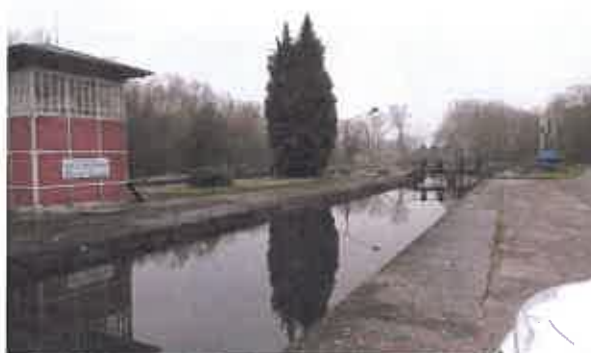
Fig. 5 : Exemple d'écluse sur le Canal de Saint-Quantin : l'écluse de Moulin Lafosse
