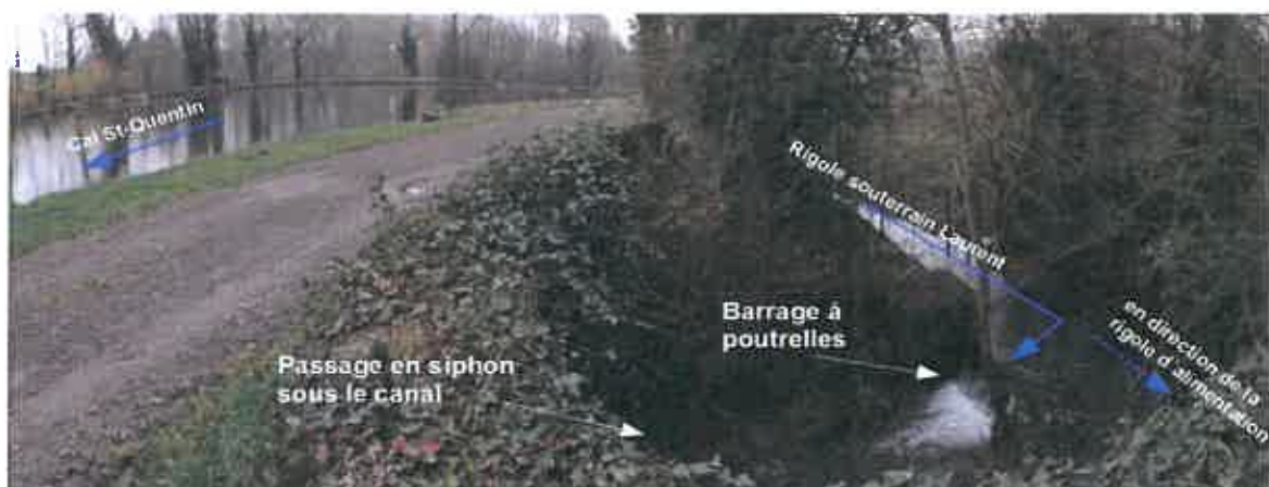
Fig.10: photo barrage à poutrelles sur la rigole du souterrain Laurent
