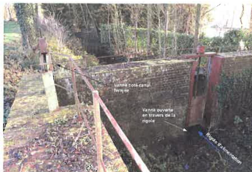
Fig.21 : Vue de la rigole d'alimentation et des ouvrages à Vaucelles
