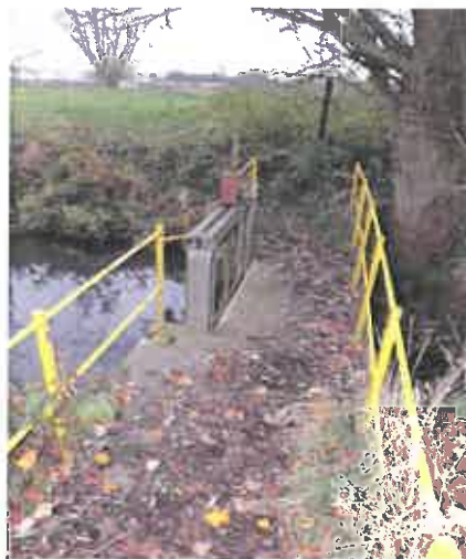
Fig.14 : Prise d'eau de Bantouzeille – en travers de la rigole d'alimentation
