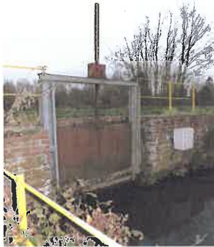
Fig.15: Prise d'eau de Bantouzelle – côté canal
