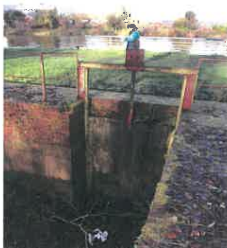
Fig.19 : Prise d'eau de Vaucelles – côté canal
