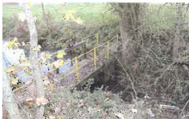
Fig.20: Vue de la rigole d'alimentation en aval de la vanne fermée
