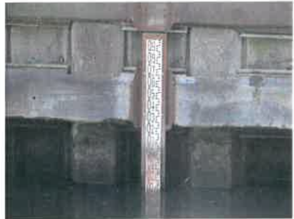
fig.17 : échelle à l'aval
