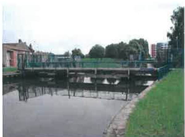
Fig.12 : Barrage vue de l'amont
