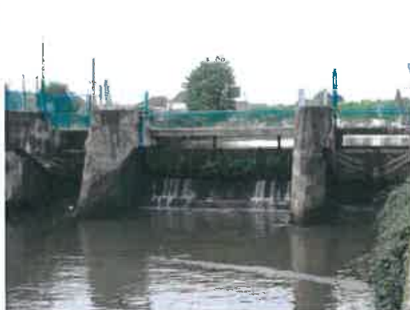
Fig.13 : Barrage vue de l'aval
