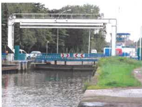
Fig.10 : Écluse vue de l'amont
