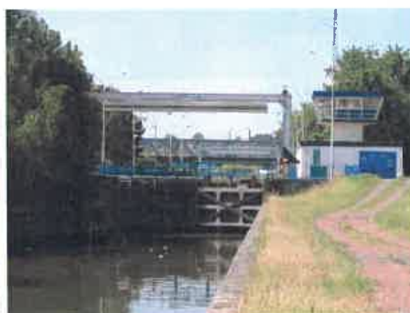
Fig.11 : Écluse vue de l'aval
