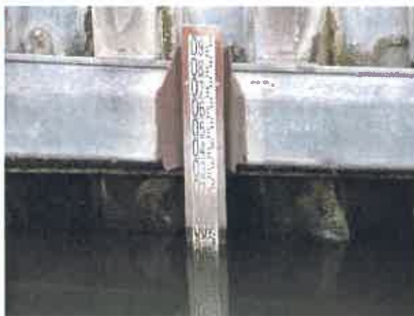
fig.20 : échelle à l'aval
