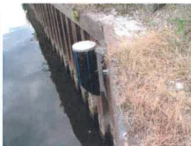
fig.22 : sonde à l'aval
