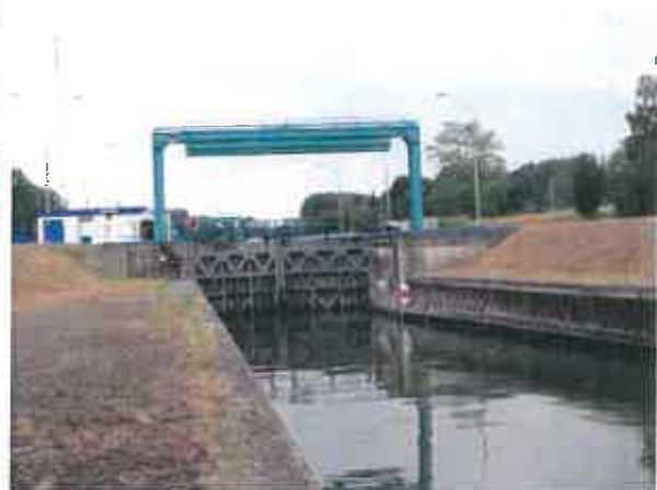
Fig.14 : Écluse vue de l'aval
