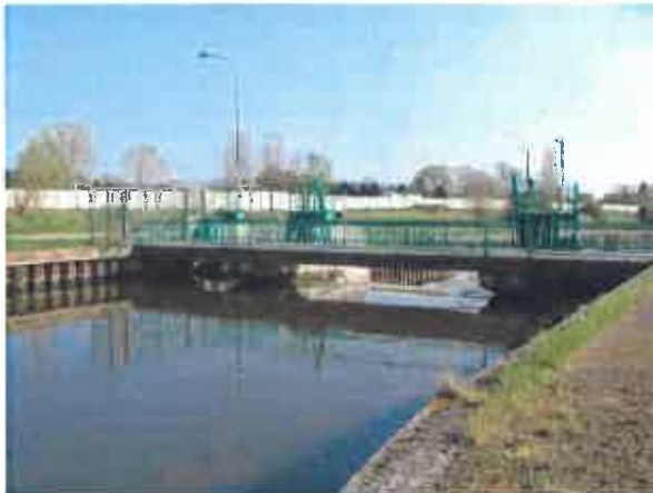
Fig.15 : Barrage vue de l'amont
