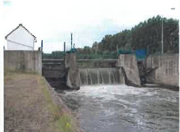
Fig.16 : Barrage vue de l'aval
