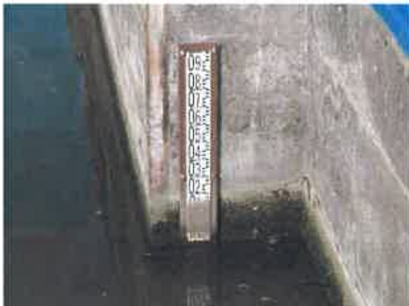
fig.19 :échelle à l'amont
