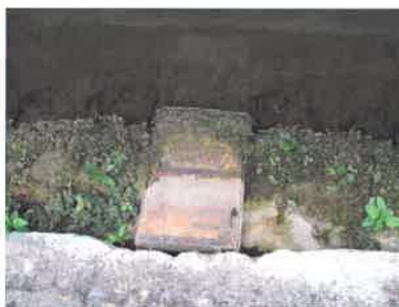
fig.12 : échelle à l'aval
