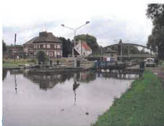
Fig.9 : Écluse vue de l'amont
