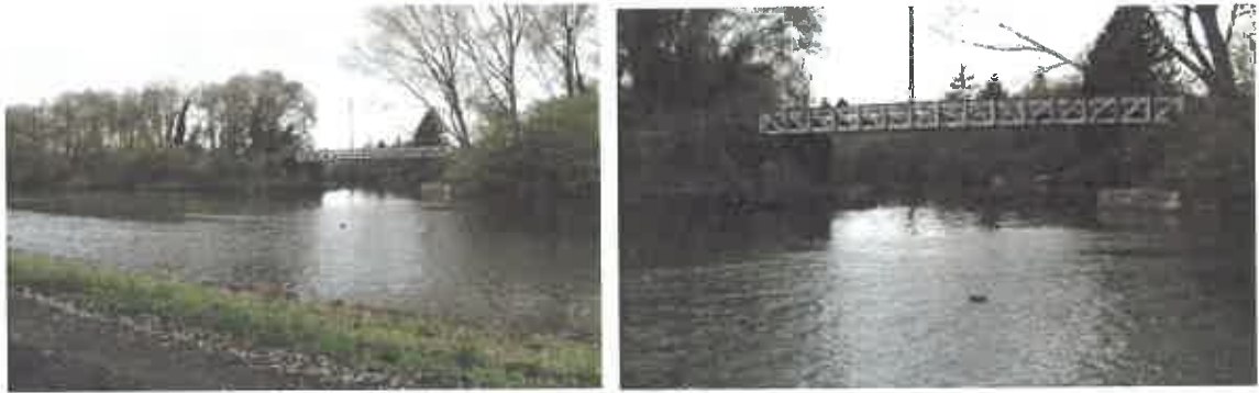
Fig.15 : Prise d'eau de la Sensée amont se rejetant dans le canal du Nord
