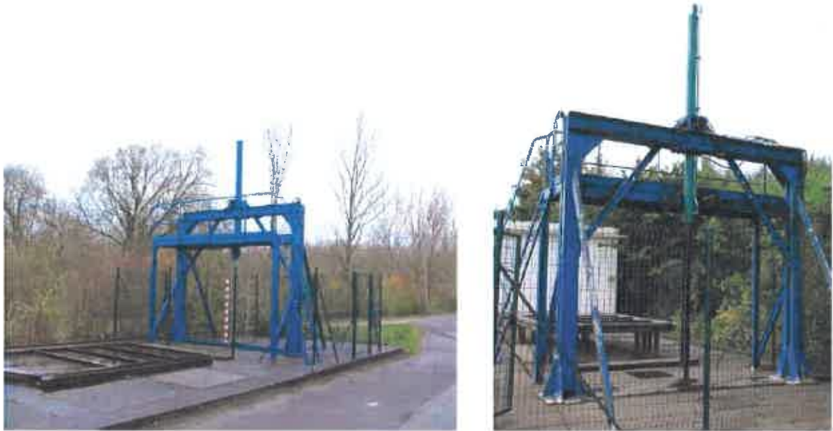
Fig.13 : Barrage vue du portique
