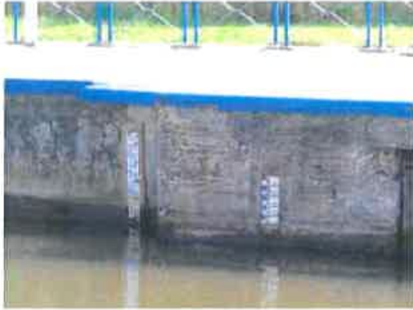
fig.16 :échelle à l'amont
