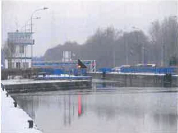
Fig.11 : Écluse vue de l'amont
