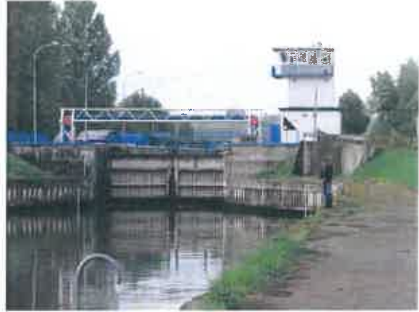
Fig.12 : Écluse vue de l'aval
