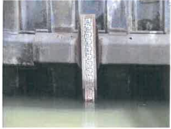
fig.17 : échelle à l'aval
